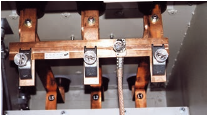
在开关装置上安装接地电缆的短路排
