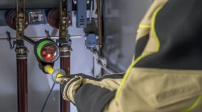
单极PHV I相位比较器在开关设备上应用
