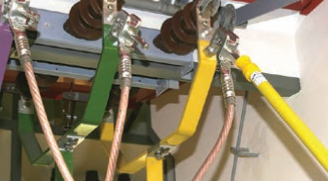
采用接地棒，使设备接地或短路
