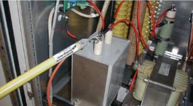
单极放电操作杆用于静电泄放
