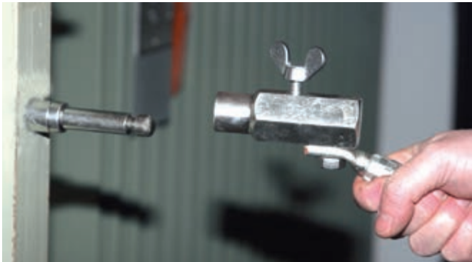
圆柱嵌件型固定接地点装置，带有接地连接件
