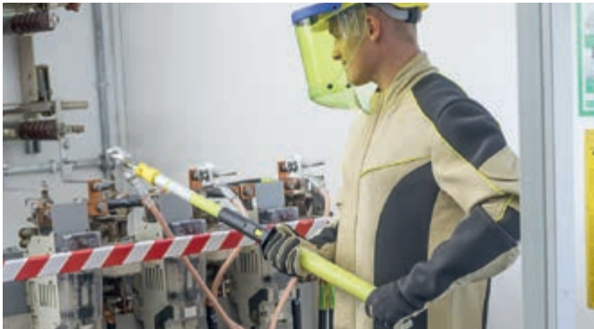
使用适当的个人防护装备，安装一个接地和短路装置
