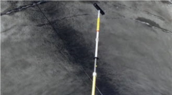
在隧道入口处移除冰柱
