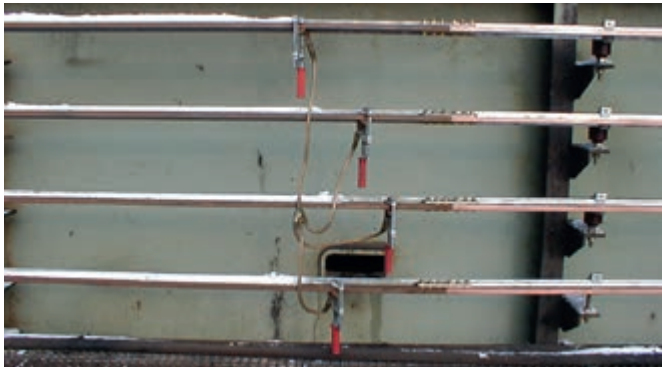
三极接地和短路装置，带螺纹夹具
