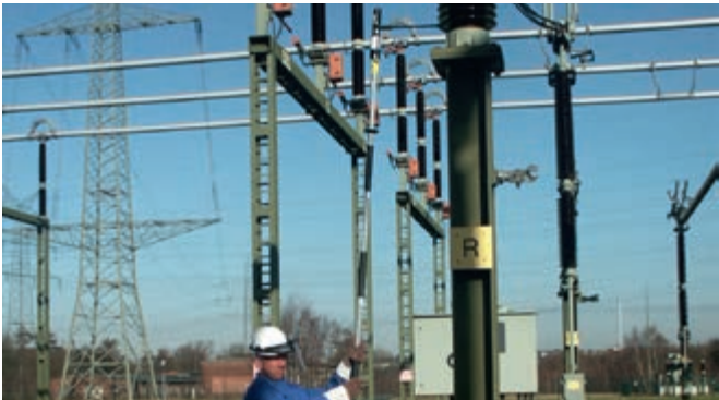
在户外配电站使用ASP非接触式电压探测器
