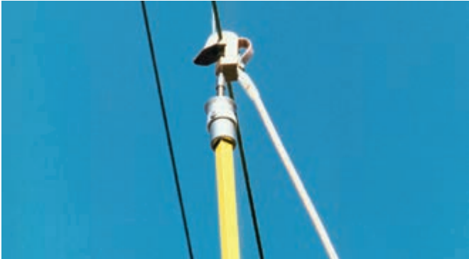
将接地夹连接到架空接触网
