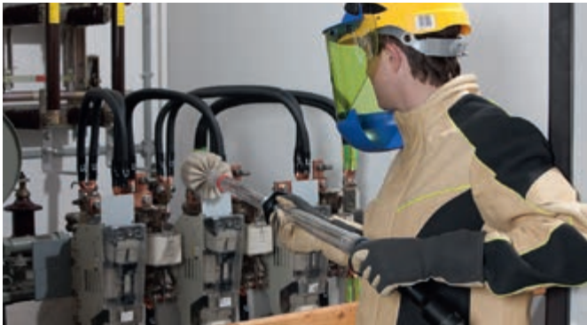
在带电环境下，使用TFRS MS 组合件对变压器进行清洁处理
