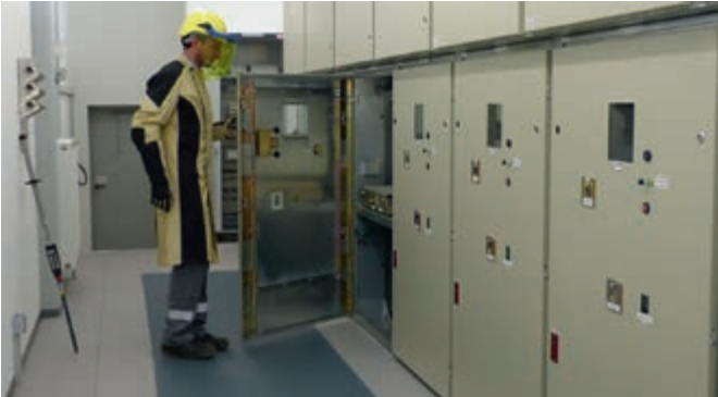
电控室地板用，绝缘垫50 kV
