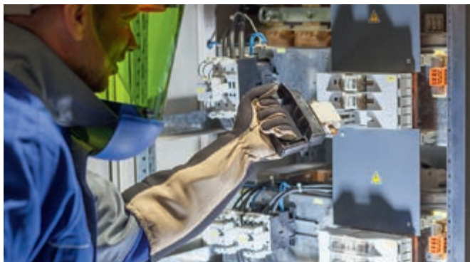
使用保护手套对NH熔丝做拔出操作
