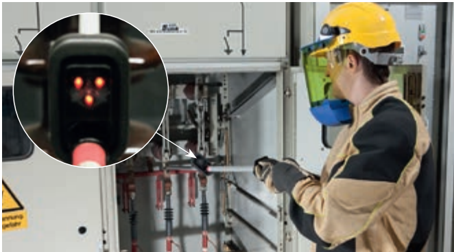
PHG II电压探测器使用在一个型式测试过的开关设备中
