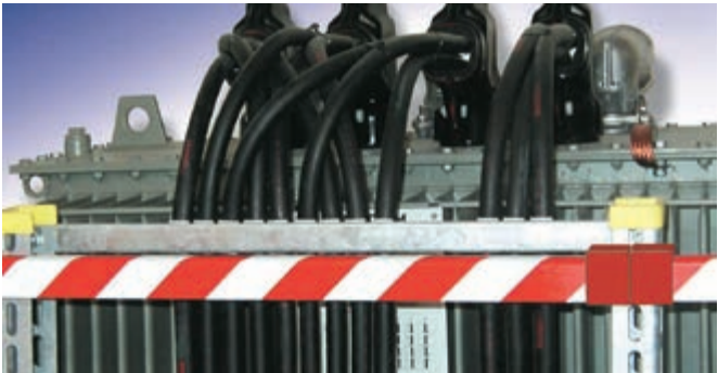
变压器站内的防护栏
