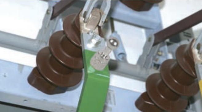
安装在母线上的直线型固定球
