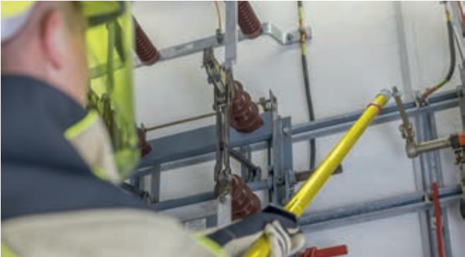
通过SCS开关棒开关一个断路器
