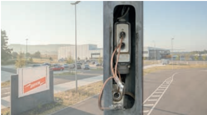
接地与短路装置安装在路灯杆内的接线盒和熔丝盒
