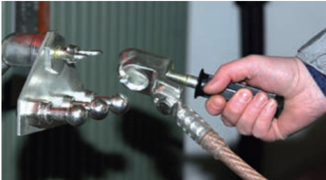
接地连接板和带塑料手柄的球头帽连接器
