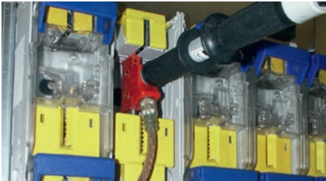
使用VI型 接地手柄安装完全绝缘的接地和短路装置
