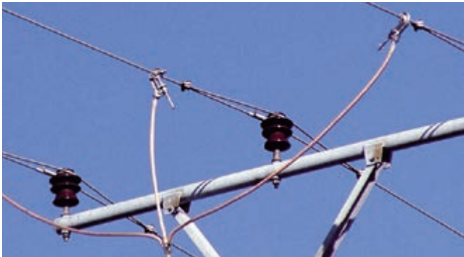
相线螺栓夹具使用在架空线
