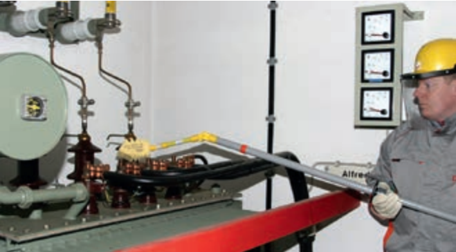
使用FRS ZK MS蒸汽清洁套件清洗变压器
