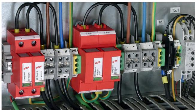
用于保护低压设备免受电涌冲击。安装于防雷区LPZ0<sub>B</sub>与LPZ1及后续分区边界处
