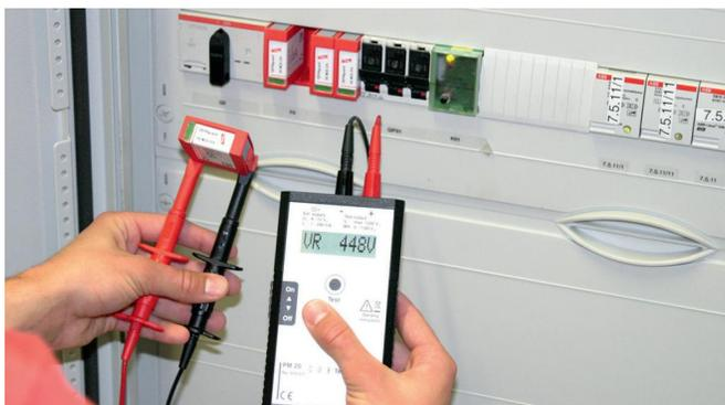
检测电涌保护器的启动电压。通过测试引线或专用检测装置与电涌保护器相连接
