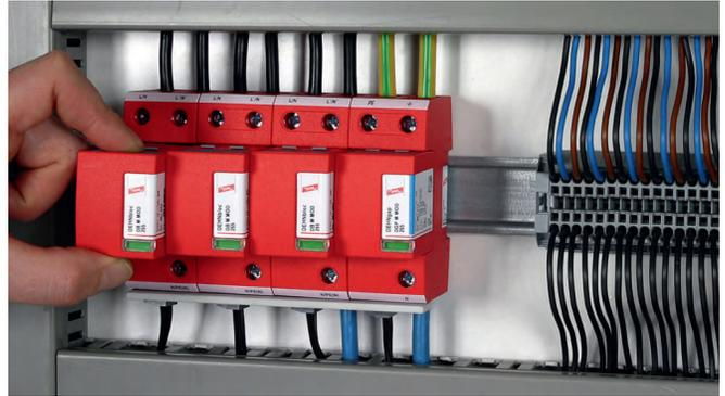
用于保护低压设备免受电涌甚至直击雷危害。安装于防雷区LPZ0A与LPZ1边界处
