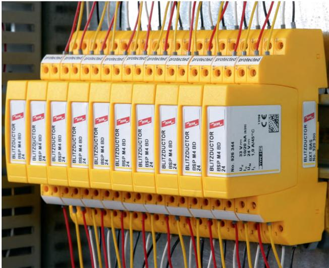
用于保护信息系统的可插拔式多极电涌保护器
