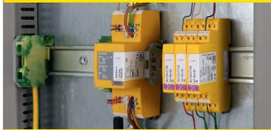
适用于DIN轨安装的紧凑型电涌保护器
