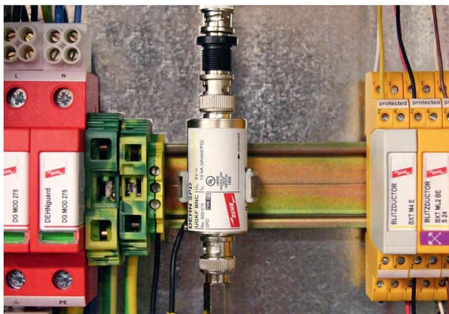
我们推荐使用DGA BNC VC系列电涌保护器，因为它更方便地安装在DIN轨上。这种节省空间的电涌保护器带有BNC接头，可保护视频和监控系统。有两种型号可供选择：DGA BNC VCD是款线缆屏蔽层进行直接接地的型号。DGA BNC VICD是款线缆屏蔽层间接接地的型号。他们都通过DIN轨接地。
