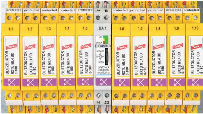
使用DEHNrecord状态监测装置的应用实例
