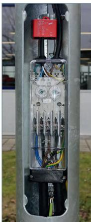
极小的安装空间里实现电涌保护。
