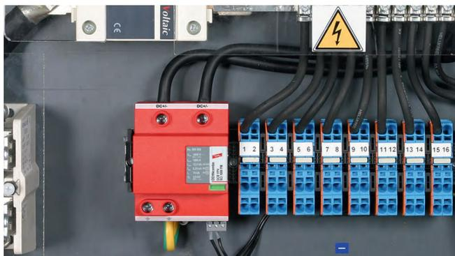
SPD依据IEC 60364-7-712《光伏电源系统的安装》。用于保护光伏逆变器免受电涌、甚至是直击雷危害
