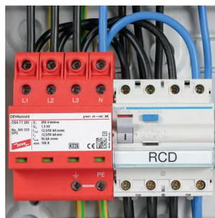
DEHNshield的凯文接线，使用通过雷电流冲击测试的STAK25针形端子
