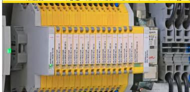
适用于DIN轨安装的可插拔式电涌保护器
