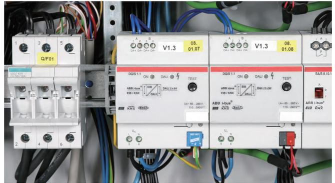
KNX / EIB总线电涌保护器，带有连接线
