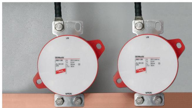
用于保护低压设备免受电涌甚至直击雷冲击。安装于防雷区LPZ0A与LPZ1边界处
