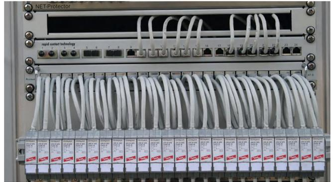
DEHNpatch是第一款拥有Cat.6A认证的网络接口电涌保护器。根据IEEE 802.3 at, 电压最高可达57V
