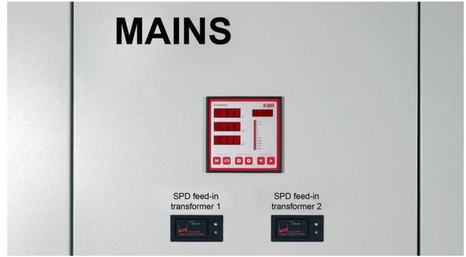
安装于开关柜的SPD的可视化指示器
