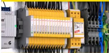
适用于DIN轨安装的端子式电涌保护器
