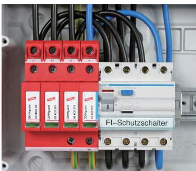
采用STAK 2 × 16对电涌保护器接线处进行EMC优化，符合IEC 60364-5-53和GB 16895-22
