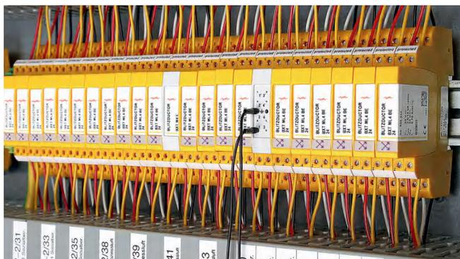
BLITZDUCTOR XT和接地模块（灰色）的应用实例。线路可以通过测量模块（灰色）测量，无需断开连接
