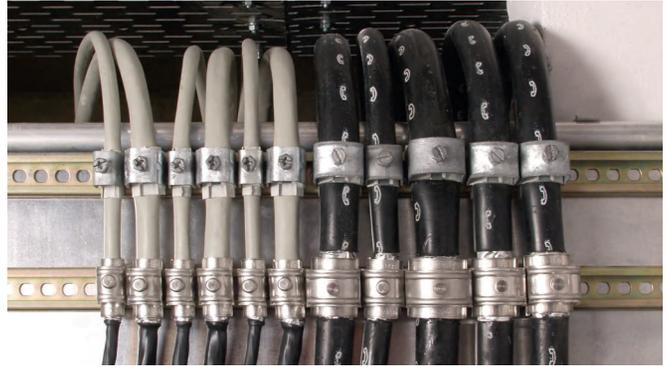
具有雷电流承载能力的屏蔽连接装置，安装在型钢上。可滑动的弹簧可补偿使用过程中线缆出现的变形
