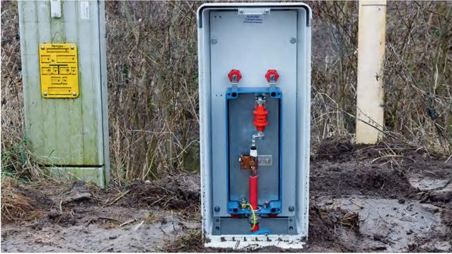
同轴连接的防爆绝缘火花间隙，用于保护埋地的绝缘接头
