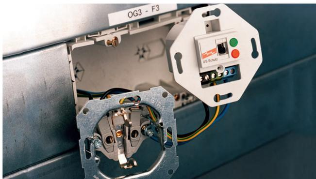
用于保护电子设备免受电涌危害。安装于电气系统，例如嵌入式接线盒和电缆管道。安装于防雷区LPZ1与LPZ2边界处或者更高的分区
