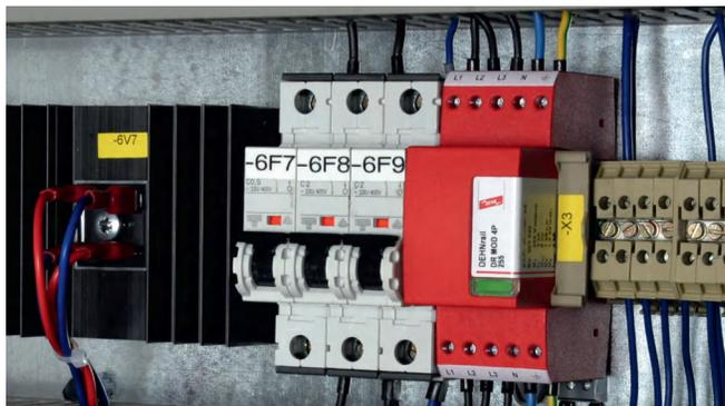
用于开关柜中工业电气设备电源线路的电涌保护。安装于防雷区1-2及后续分区
