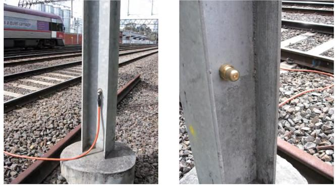
EN 50122-1说明了直流和交流控压装置的使用方法，作为架空接触网和受电弓区域的导电部件，被用于“开放式牵引系统接地”的牵引系统。SDS控压装置用于防止绝缘轨道或电气化铁路轨道段与设施接地之间发生危险电涌。
