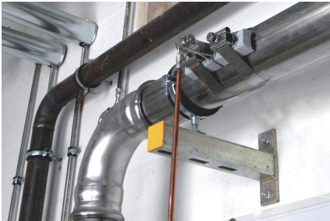
管道夹安装在不锈钢管道
