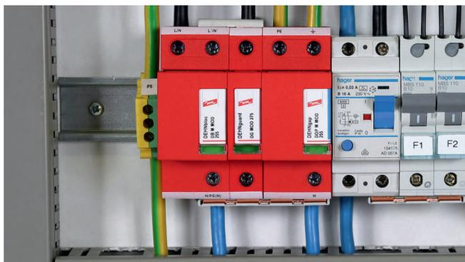
用于保护低压设备免受电涌甚至直击雷危害。安装于防雷区LP2<sub>A</sub>与LPZ1边界处（3+1电路）
