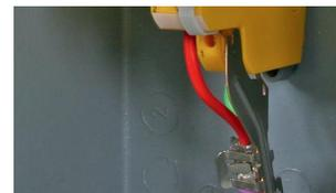
EMC弹簧端子(配件)用于低阻屏蔽连接
