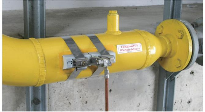
管道夹用于爆炸危险区的电气连接，根据IEC / EN 62305-3 / GB/T 21714.3标准实现防雷等电位连接
