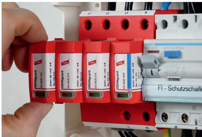
用于保护低压设备免受电涌甚至直击雷危害。安装于防雷区LPZ0<sub>B</sub>与LPZ1边界处
