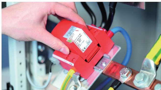
用于保护低压电气装置免受直击雷和电涌冲击，安装于防雷区LPZO<sub>A-2</sub>
