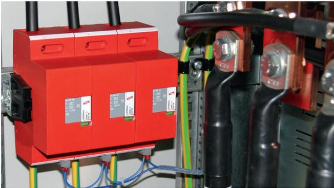
用于保护低压电气装置免受直击雷和电涌危害，安装于防雷区LPZ0A-1
