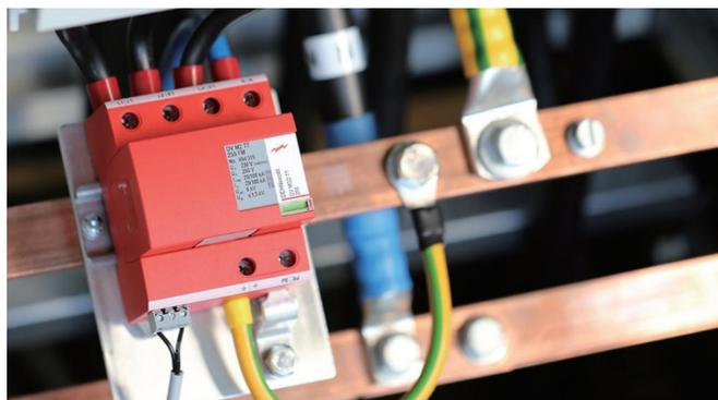
用于保护低压电气装置免受直击雷和电涌冲击，安装于防雷区LPZO<sub>A</sub>-2
