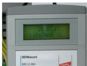
可显示测试结果的DRC LC M3+
