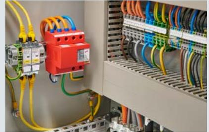
小巧的结构设计为优化利用现有空间创造了新的可能。也可以侧面安装，这样更容易遵循 0.5 米的接地线长度 还可以旋转 180° 安装。
