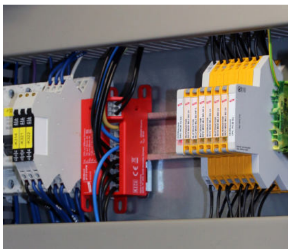
图 17 BLITZDUCTORconnect 在建筑机电设备中的使用示例
