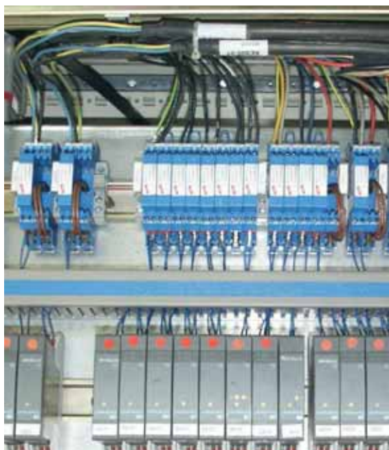
图9.15.6 用于本质安全电路的BCT MOD MD EX 24
