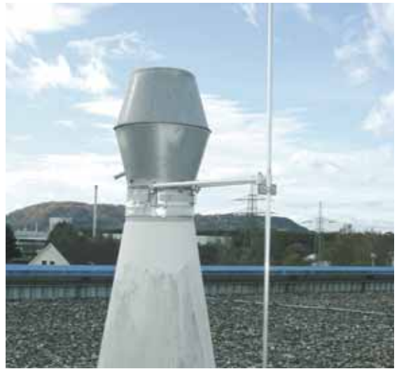
图5.1.8.3 带有隔离支撑的接闪装置
