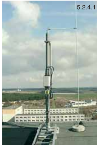
图5.2.4.1 带有间隔保持器的隔离接闪装置
