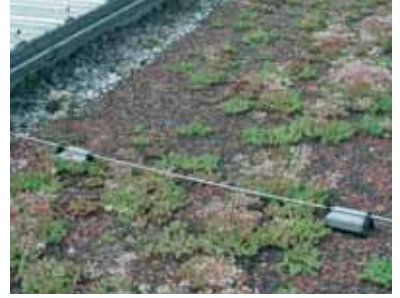
图5.1.7.3 在屋顶覆盖层中电缆的走线
