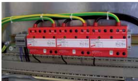
图 9.16.4 能量协调的雷电流保护器的应用，DEHNbloc Maxi 用于400/690V的 TNC系统
