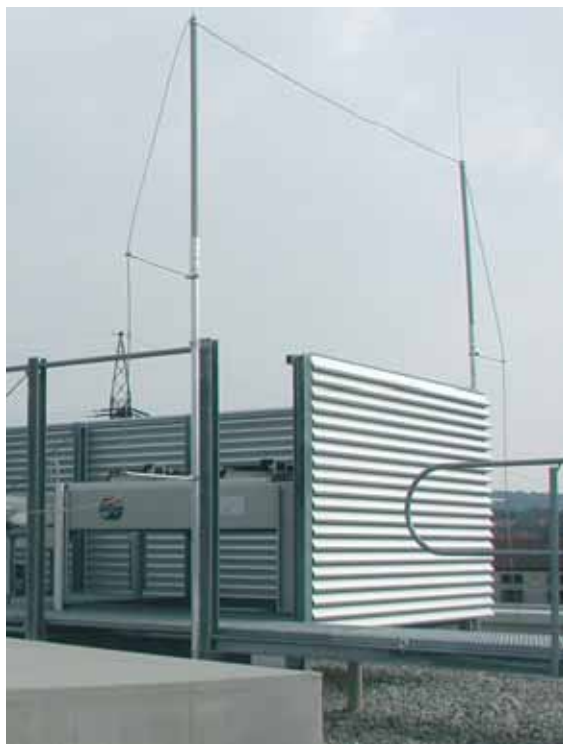
图5.1.8.14 带有DEHNiso-Combi 的隔离接闪装置
