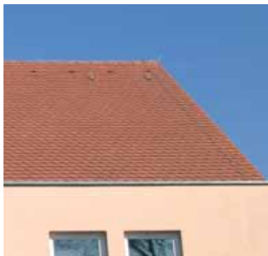
图5.1.2.1 斜面屋顶上的接闪装置
