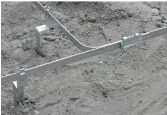
图5.5.2.3 基础接地体
