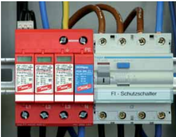
图7.8.1.2 DEHNguard TT H LI - 多极电涌保护器, 具有使用寿命三段指示
