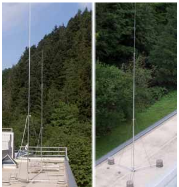
图5.1.11.1 独立式接闪装置, 用于防范直接雷击
