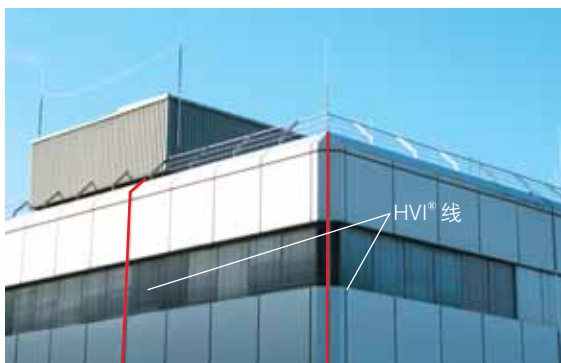
图5.2.4.2.5 带有避雷线和绝缘导线的接闪装置
