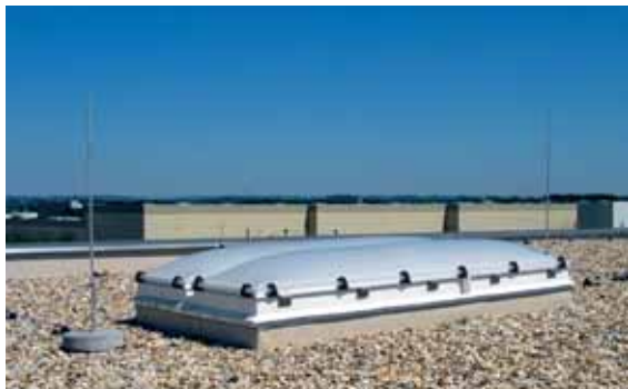
图5.1.1.17 使用避雷针保护小型屋顶设施
