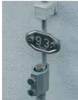
图5.2.2.3.1 测试点处标有号码
