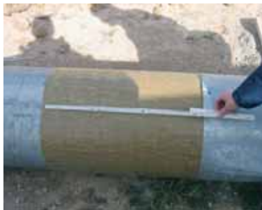
图5.1.8.8 在连接区中，用于地下的防腐保护带
