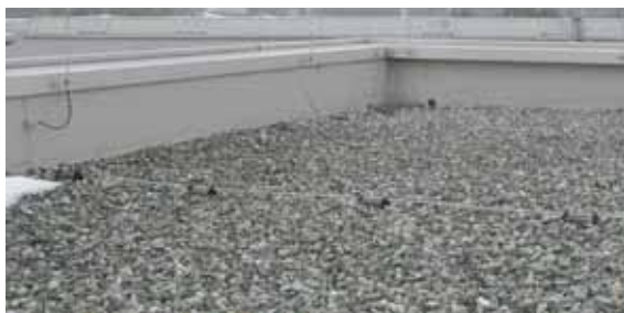
图5.1.3.2 在平屋顶上的接闪装置
