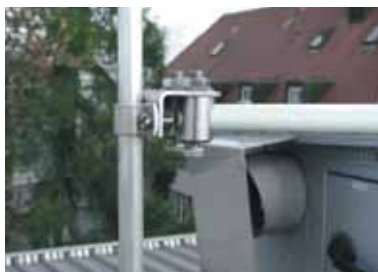
图5.1.8.5 接闪杆的支撑件
