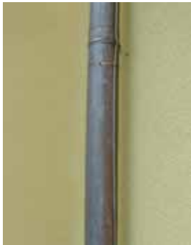
图5.2.2.2.4 排水管的引下线
