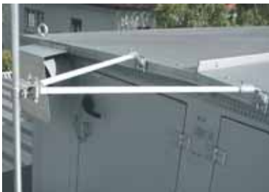
图5.1.8.4 接闪装置的角形支撑
