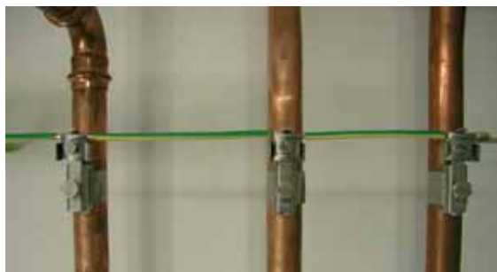
图6.1.6 用于直通连接的等电位连接
