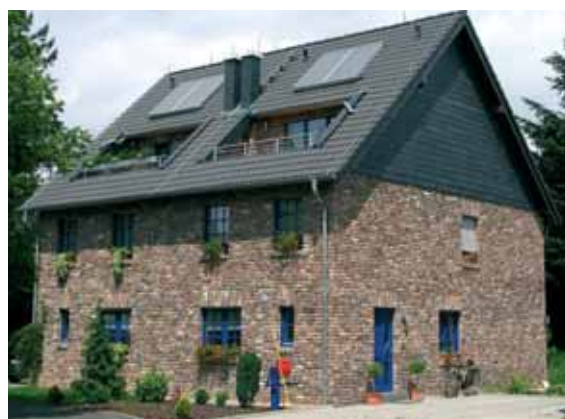
图5.1.2.4 安装了光伏设备的建筑物 来源：Wettingfeld, Krefeld地区的雷电防护
