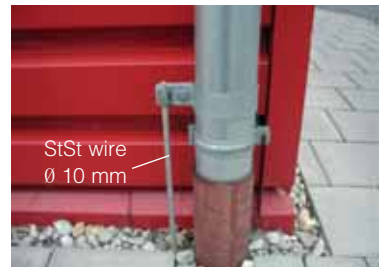
图5.2.2.1.4 排水管接地
