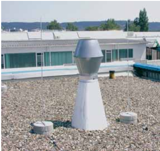
图5.1.8.2 隔离的接闪装置
