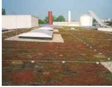
图5.1.7.2 植被屋顶的接闪装置
