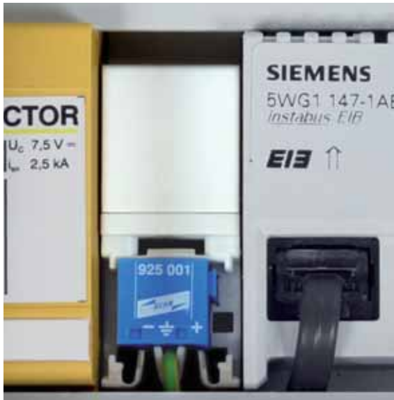
图9.10.1 BUStector的应用 (货号: 925 001)
