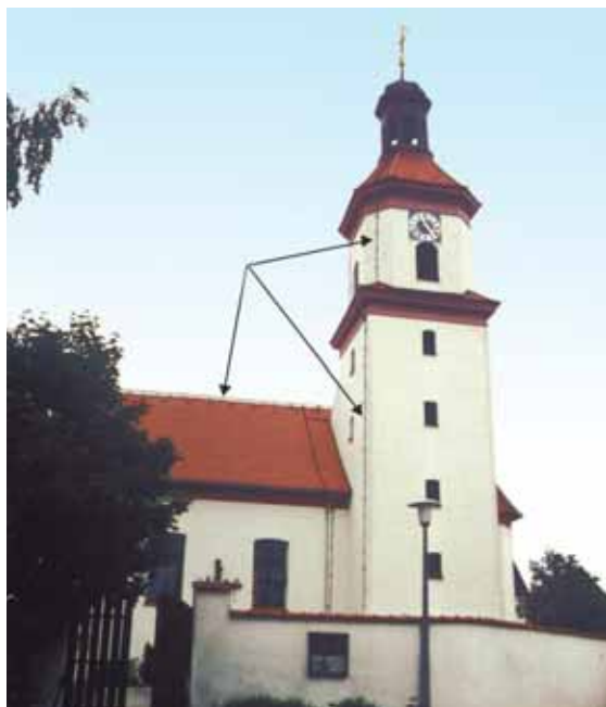
图5.1.9.1 在教堂上布置闪电线
