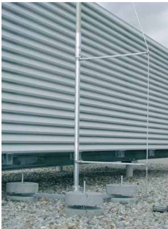
图5.1.8.11 独立支撑的三脚架
