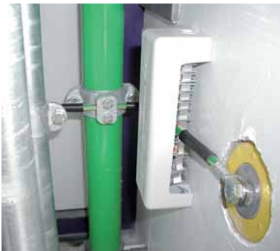
图7.5.1.1 等电位连接排（EBB）连至固定接地点
