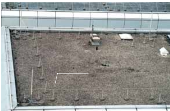
图5.2.4.2.3b 避雷针和建于支架上的环形导线，与绝缘引下线系统相连
