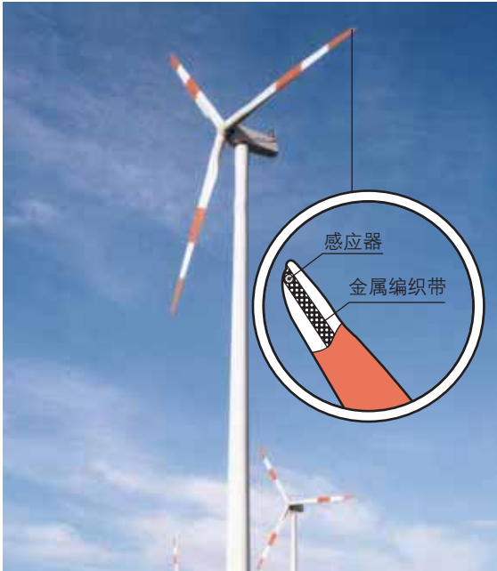
图5.1.10.1 在风叶上安装了感应器
