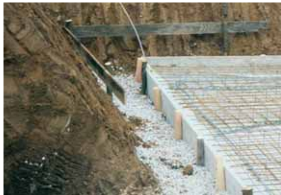
图5.5.2.4 基础接地体的应用
