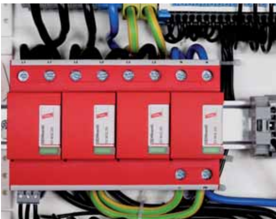
图7.8.1.3 DEHNventil M TNS - 模块式复合型保护器
