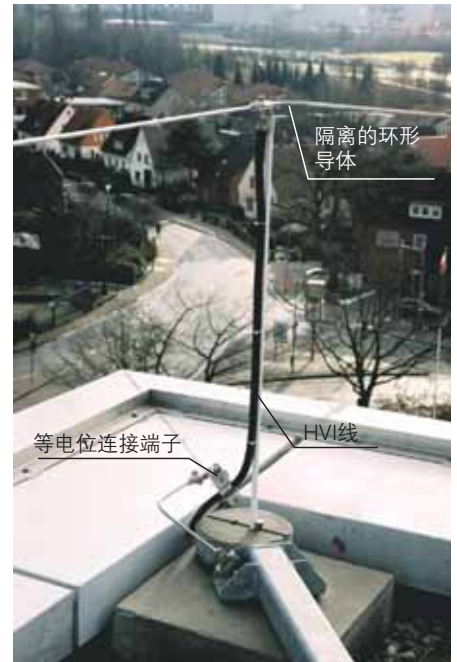
图5.2.4.3.3 隔离环形导体用作引下线
