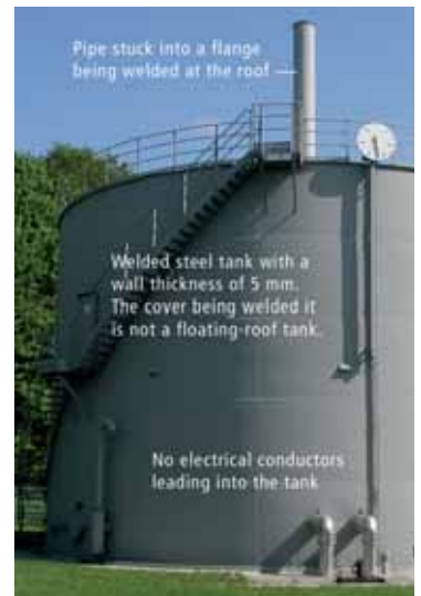
图9.3.8 焊接的钢罐（来源：Eisenbau Heilbronn GmbH）
