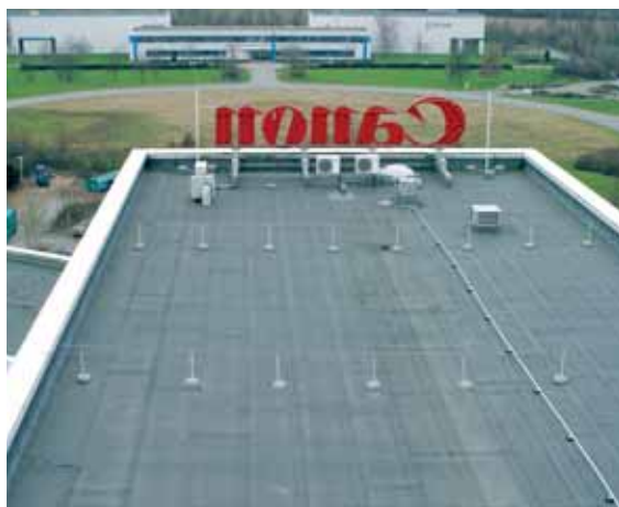
图5.1.8.10 已安装的接闪装置 来源：德国 Krefeld，Wettingfeld 的雷电保护
