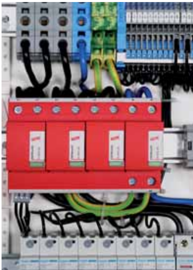
图9.15.4 开关柜中用于保护 供电系统的 DEHNventil DV TT 255
