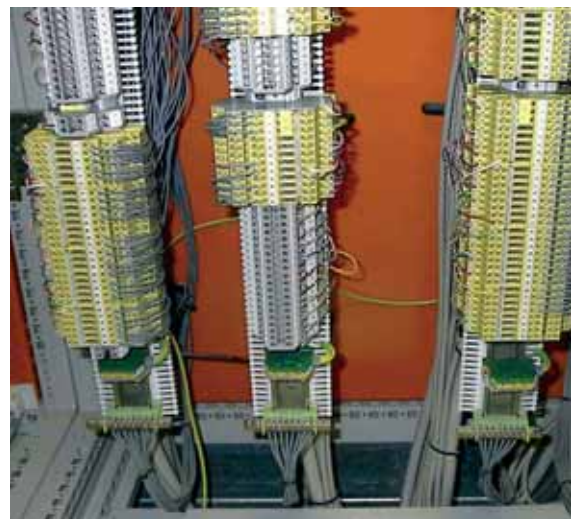
图9.4.8 电涌保护器DCO ME 24，安装在开关柜中，从双层底板进线
