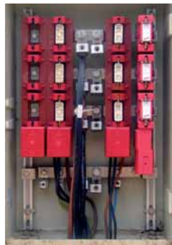
图8.1.6.6 用在NH保险丝底部的2级电涌保护器V NH
