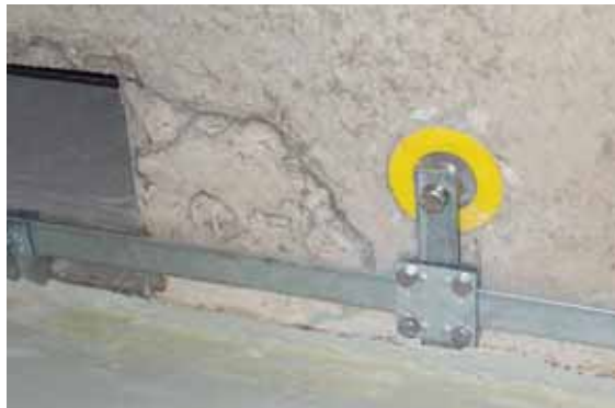
图7.7.1.1 环形等电位连接和连接金属装置的固定接地点
