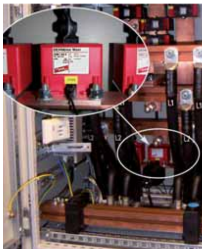
图8.1.6.5 DEHNbloc Maxi S: 带有内置后备熔丝的能量协调型雷电流保护器，用于汇流排安装
