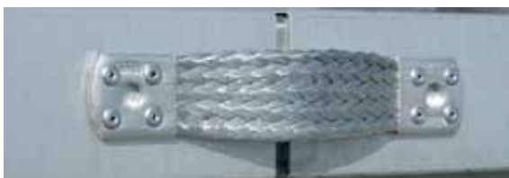
图5.1.3.4 建筑拦墙的桥接
