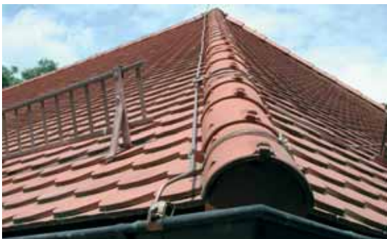
图5.1.1.18 带有线束支架的坡面屋顶
