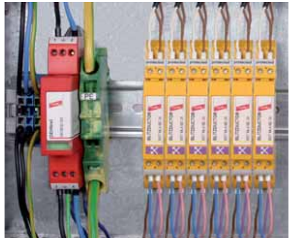
图9.16.6 复合型雷电流/电涌保护器 BLITZDUCTOR XT的应用
