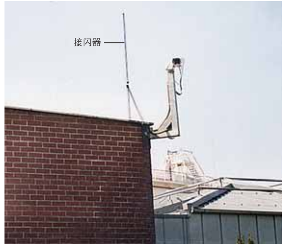
图9.7.2 在接闪器保护范围内的监控摄像机
