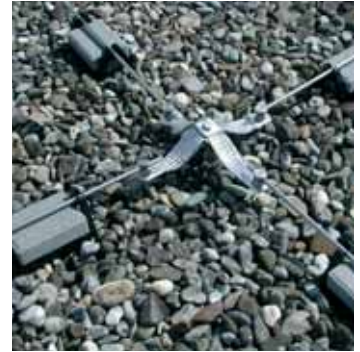
图5.4.1.1 接闪装置 - 采用桥接带进行膨胀补偿
