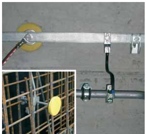
图5.5.2.8 固定接地端子
