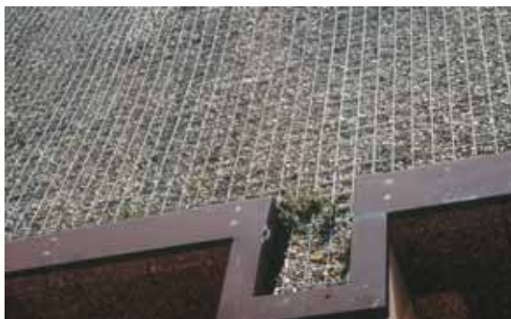
图7.3.7a 镀锌的钢筋网，用于建筑物的屏蔽
