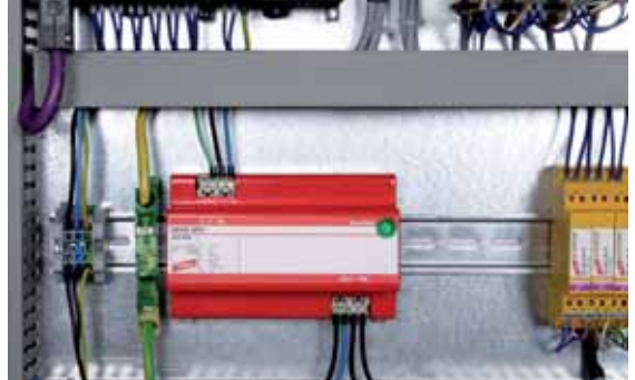
图7.7.3.1 BLITZDUCTOR CT和SPS电涌保护器, 用于工业电子设备的保护 (如: SPC)
