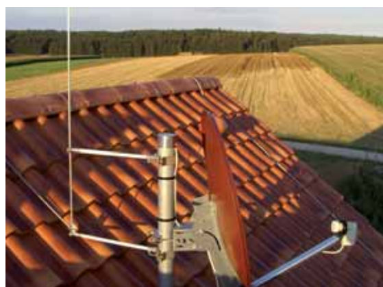
图5.1.2.5 带有接闪装置的天线 来源：Oberosterreichischer, Linz的防雷保护
