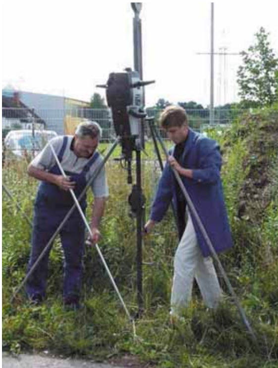
图5.5.4.2 使用工作架和震动锤，将垂直接地体打入地下
