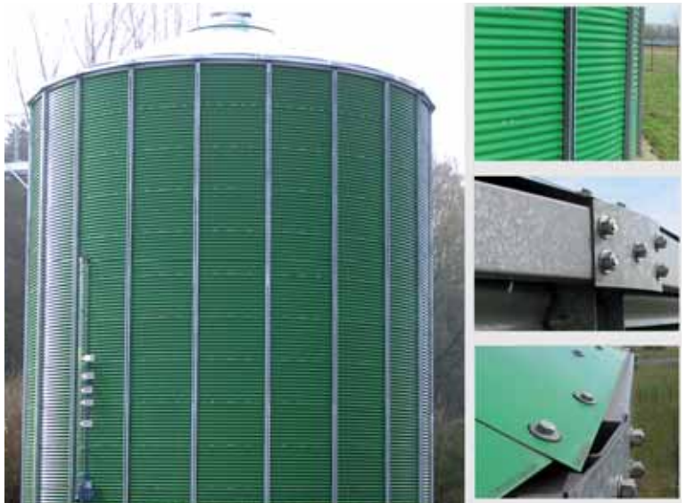
图9.3.6 用螺丝紧固金属板制成的发酵桶
