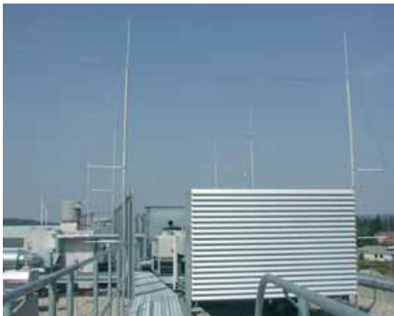
图5.1.8.12 带有DEHNiso-Combi 的隔离接闪装置
