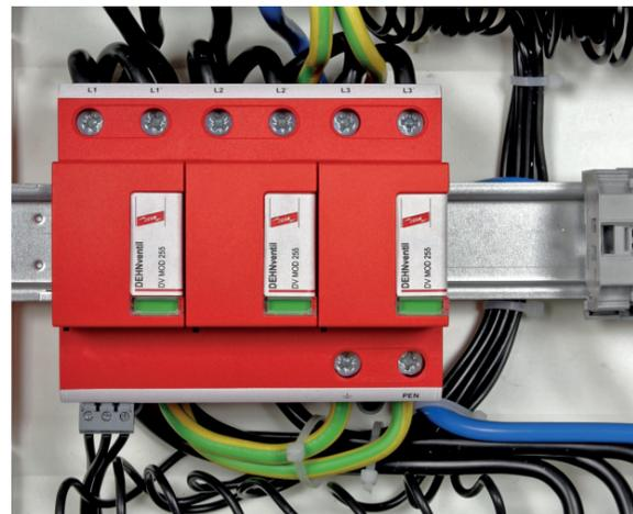
保护供电系统的电涌保护器
